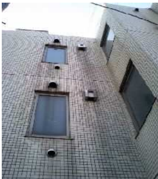
タイル外壁 汚ダレ除去・除菌洗浄
