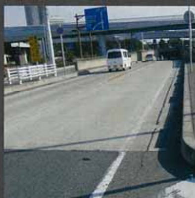
■ 国道・地覆補修工事 / 地覆
