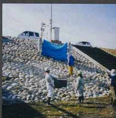
■護岸防水修繕工事／路肩護岸
