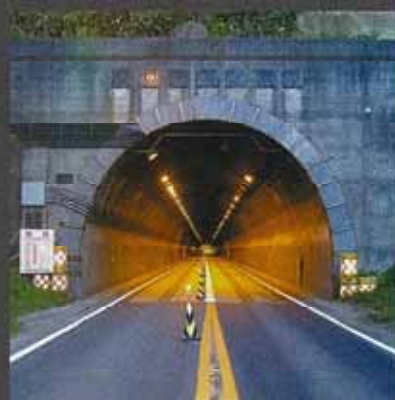
■ トンネル内壁補修工事 / トンネル内壁
