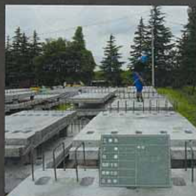
■PC板改質工事／PC板工場施工
