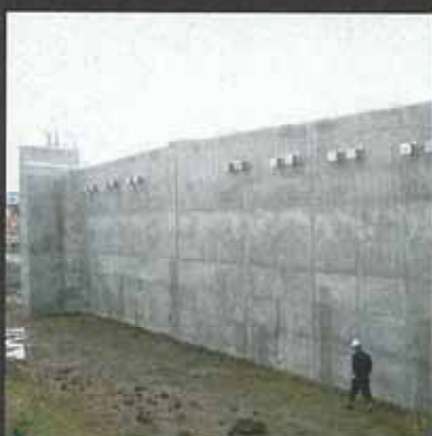
■鉄輪橋下部工事／橋台
