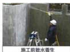
施工前散水養生
