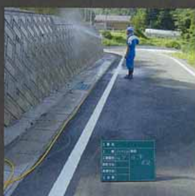
■積ブロック改質・補修工事／積ブロック
