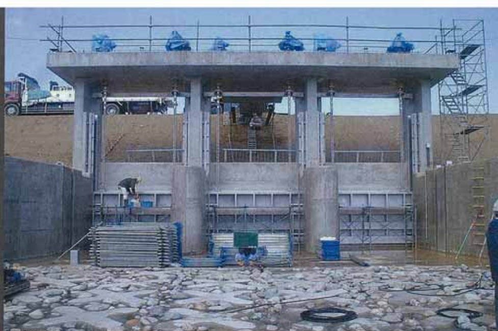
■排水樋門新設工事／排水樋門
