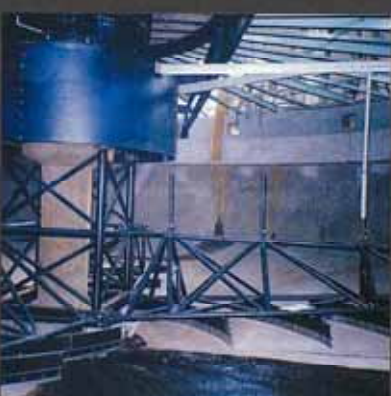
■汚泥槽補修工事／汚泥槽内
