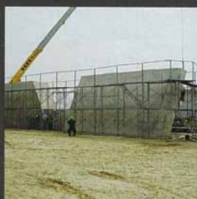
■道路橋新設工事／橋脚
