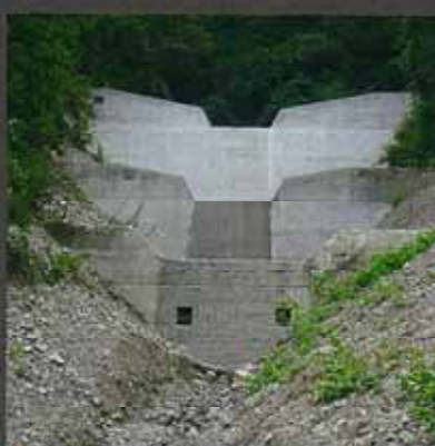
■砂防ダムクラック抑制工事／谷止止部
