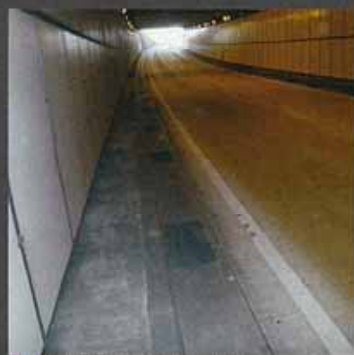
■ トンネル内床補修工事 / トンネル床面
