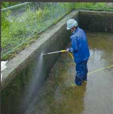
■防火水槽改修工事／構内
