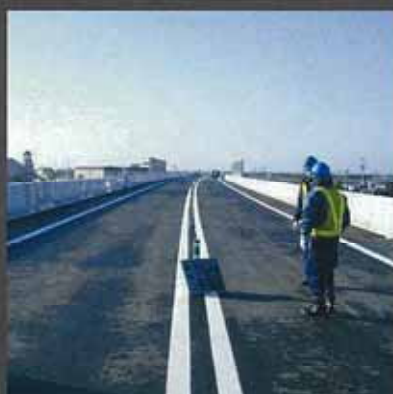
■ 高速自動車道補修工事 / 高欄
