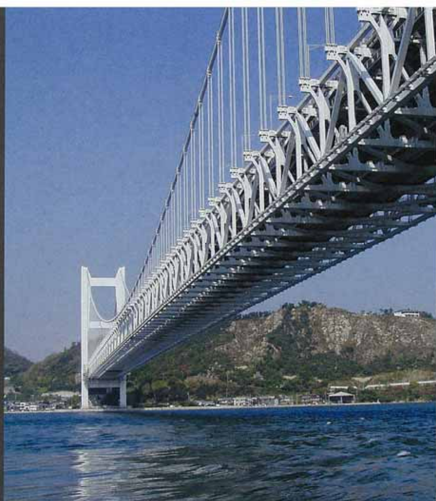
■自動車道基礎補修工事／基礎
