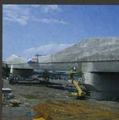
■鉄道上部工他新設工事／床版高欄
