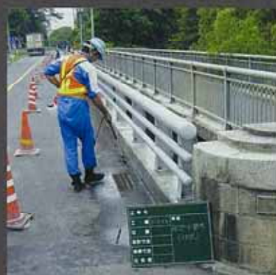
■ 橋梁補修工事 / 橋梁地盤
