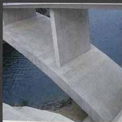
■道路橋補修工事／橋梁下部
