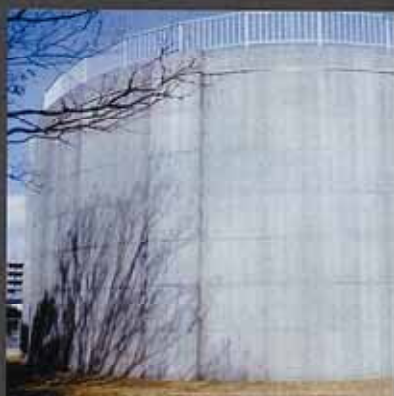
■配水池外壁改修工事／外壁・屋上
