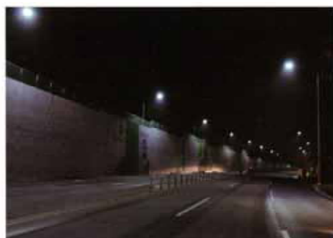
LED街路灯設置
