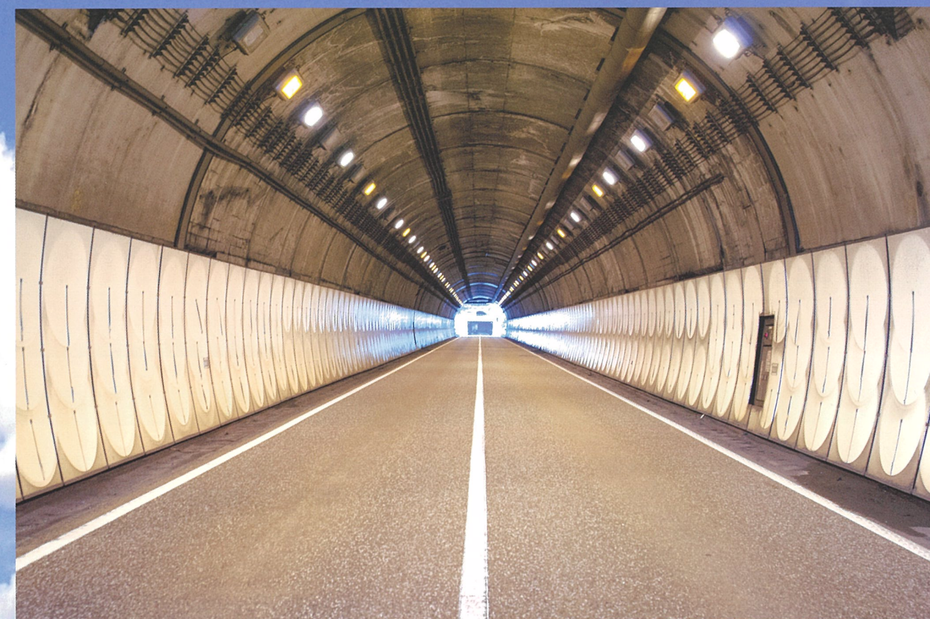
富山県国道8号線横尾トンネル（H26年10月撮影）
