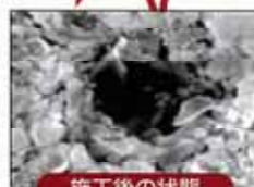
施工後の状態
